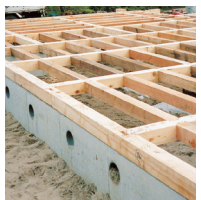
剛床工法 床剛性3.7倍 大引工法
